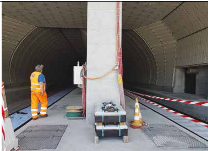
2. L'imbocco della galleria di base del Ceneri
