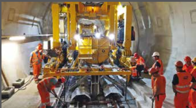
10. I quattro aghi vibranti garantiscono la mancanza di bolle d'aria e di vuoti
