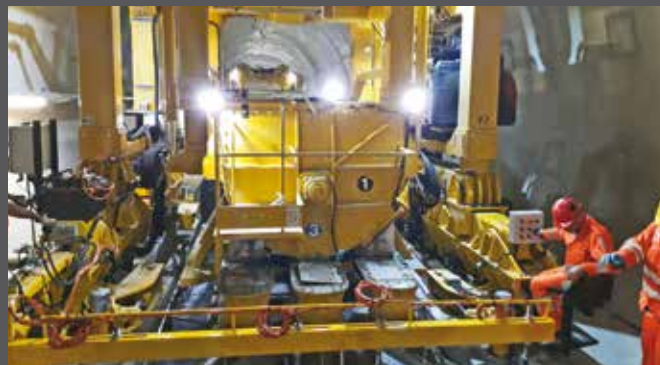
12. Le operazioni del getto controllate scrupolosamente dal Personale GCF
