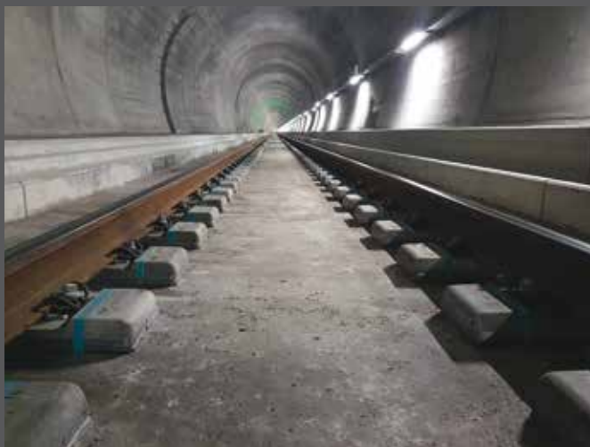
7. I binari posati e allineati in senso laterale e altimetrico
