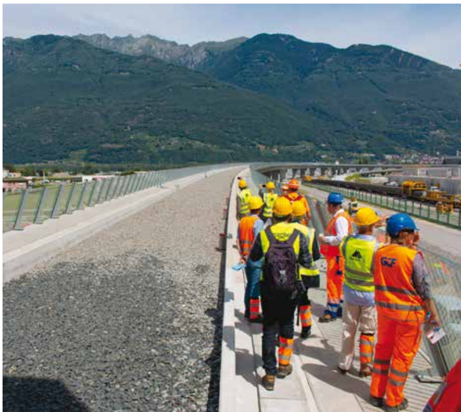
3. Vista dal viadotto ferroviario in ballast
