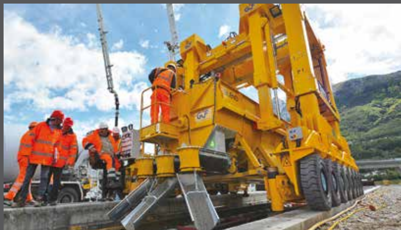
5. La posa in opera del calcestruzzo della prima tratta mostra
