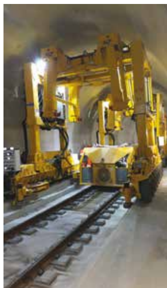
16A, 16B e 16C. Il ciclo operativo di alimentazione del calcestruzzo in galleria
