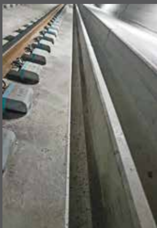
11A e 11B. La canaletta di scolo e di raccolta delle acque è un preciso punto di riferimento per il getto
