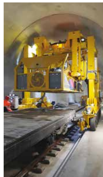
16A, 16B e 16C. Il ciclo operativo di alimentazione del calcestruzzo in galleria
